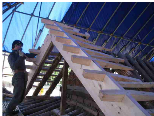
사진 52. 목기연 설치
