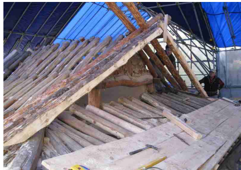
사진 50. 함각부 집우사 설치
