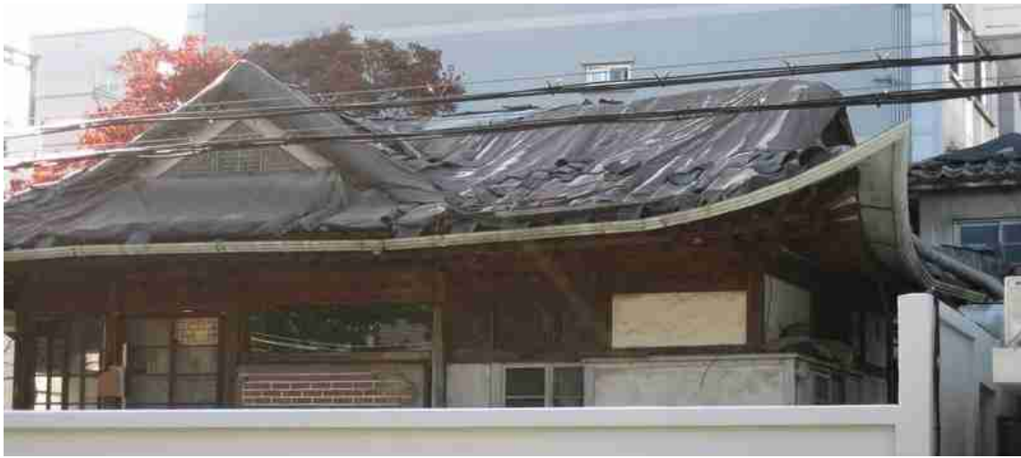
사진 6. 안채 동측면 전경(보수 전)
