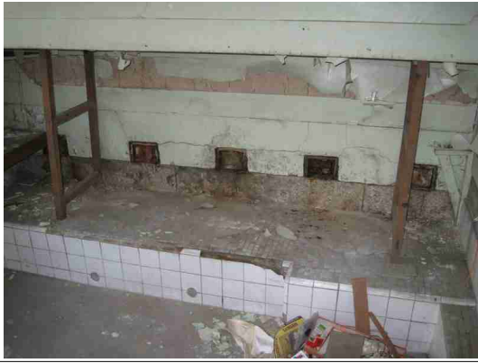
사진 19. 부엌 현황(보수 전)
