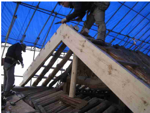
사진 51. 박공널 설치
