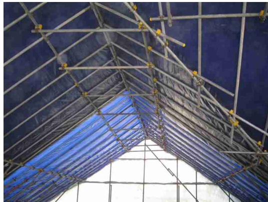
사진 26. 가설 덧집 공사 완료
