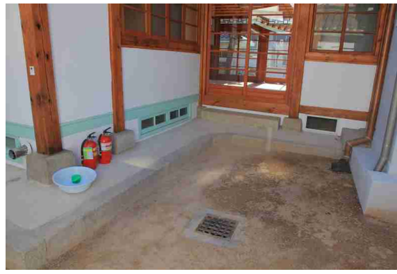
사진 30. 배면 디딤돌과 기반석 재설치
