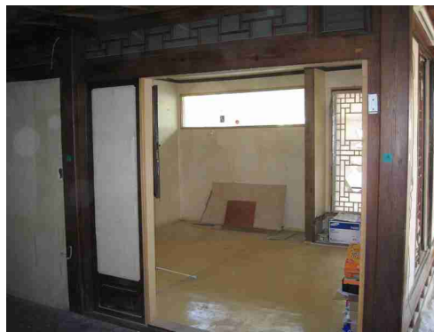
사진 14. 안방 현황(보수 전)
