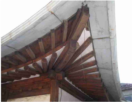
사진 22. 정면 우측 추녀부근 현황 (보수 전)
