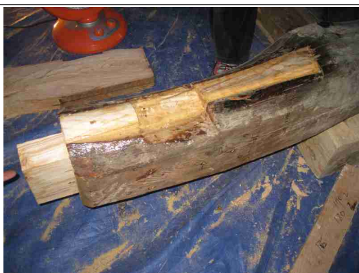
사진 41. 건넛방 대량 손상부 수리
