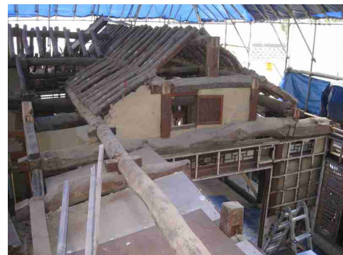
사진 35. 건넌방 상부 가구 해체
