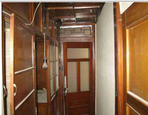
사진 18. 복도-2 현황(보수 전)
