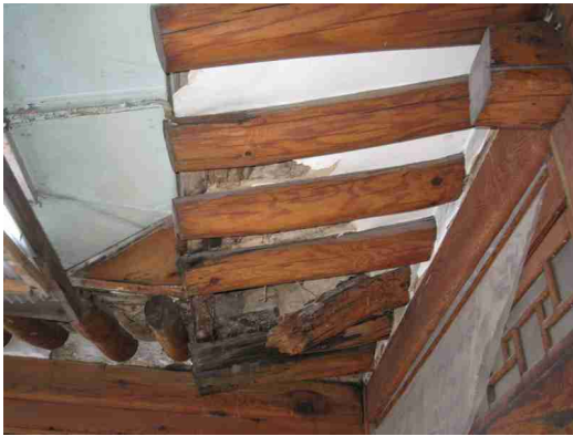
사진 21. 배면 안채 출입구 처마 현황 (보수 전)
