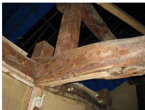
사진 42. 수리한 대량 설치
