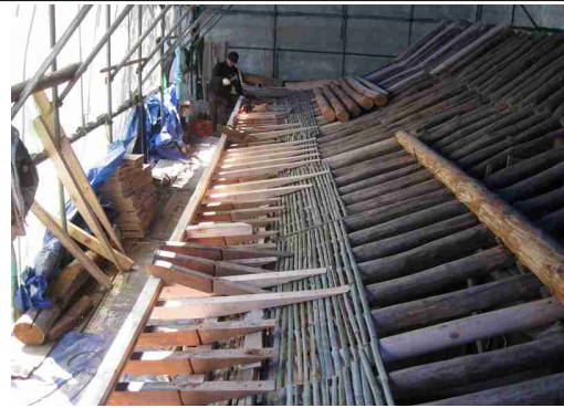
사진 48. 부연 설치
