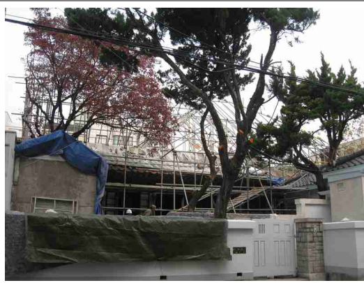
사진 24. 가설 비계다리 설치
