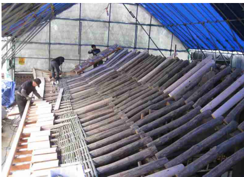
사진 49. 부연 개판 설치
