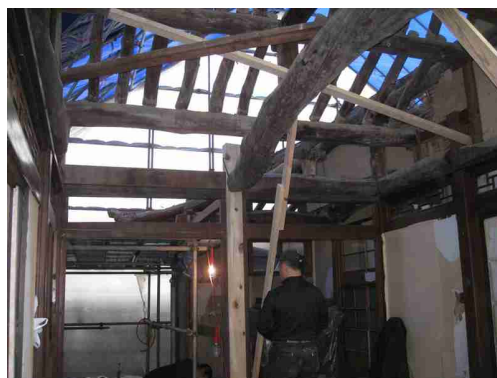
사진 40. 배면 기둥 해체 후 재설치
