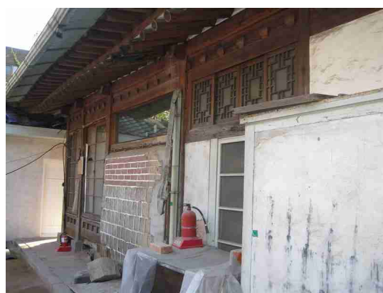
사진 8. 안채 우측면(동)(보수 전)
