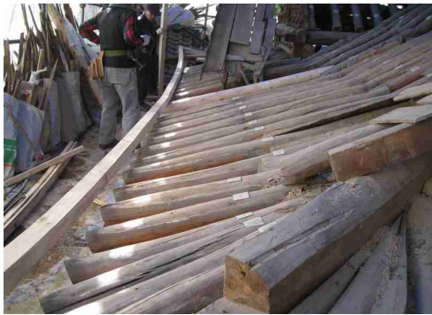
사진 47. 평고대 설치
