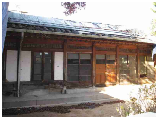
사진 7. 안채 정면(보수 전)
