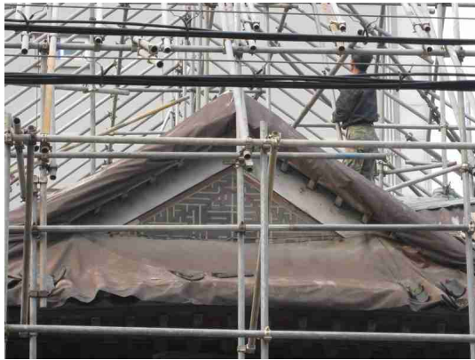
사진 25. 쌍줄비계 및 가설 덧집 설치 중
