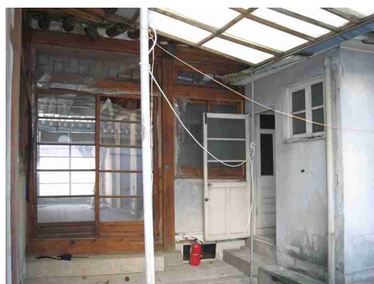
사진 10. 안채 배면(북) (보수 전)
