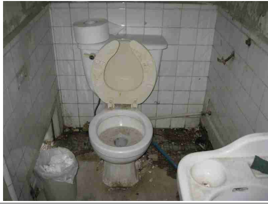
사진 20. 화장실 현황(보수 전)
