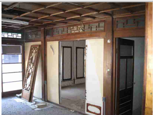
사진 17. 건넌방 현황(보수 전)
